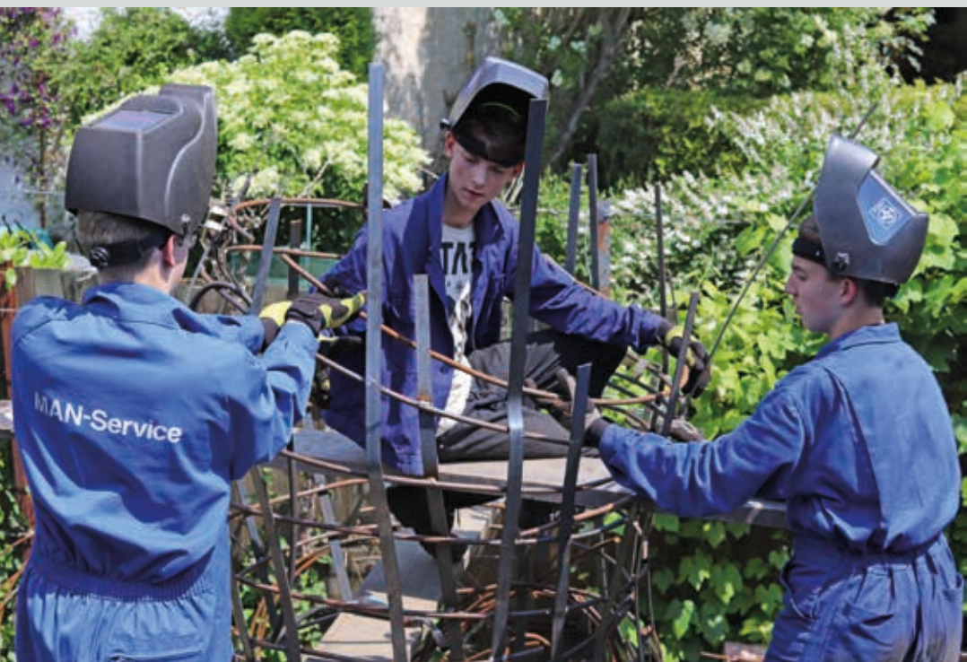
Arbeiten im und am Grundgerüst oder auch „Skelett“ des Drachen.
